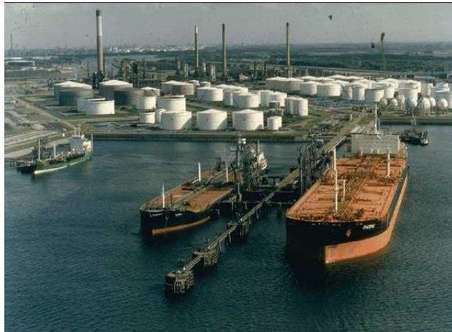
Muelle en alta mar para buques a granel líquido
